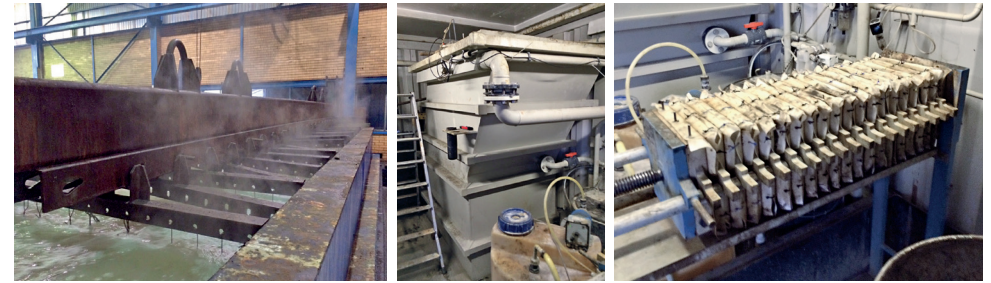
Biologisches Entfettungsspülbad / Schrägklärer / Kammerfilterpresse (v.l.n.r. Fotos Balczyk, IBV HSMA)
